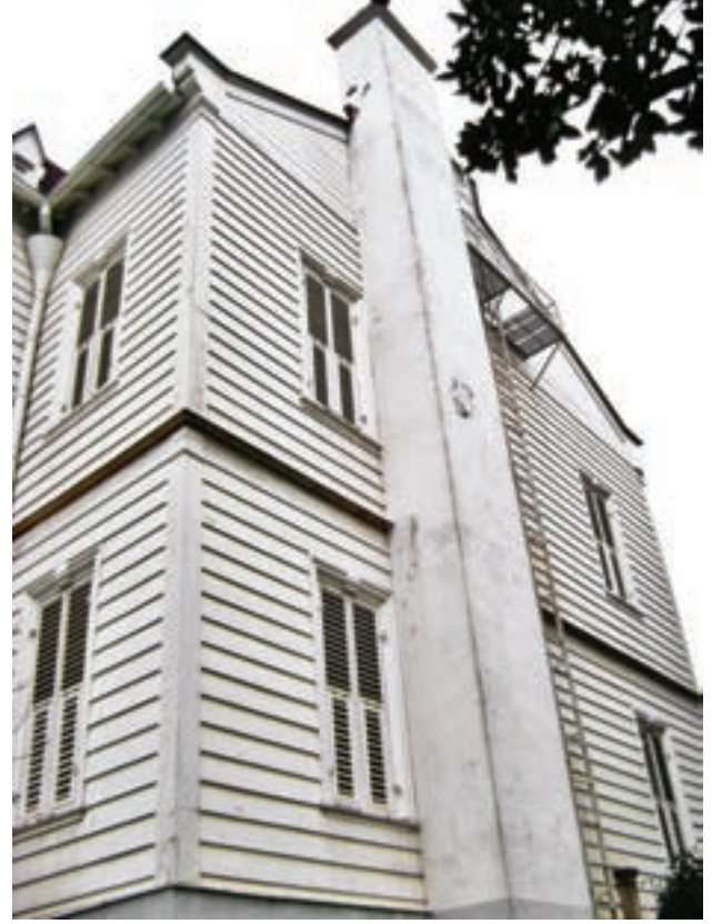
9 Kalorifer tertibatı için yapılmış, ana bina dış cephesinden yükselen baca.
