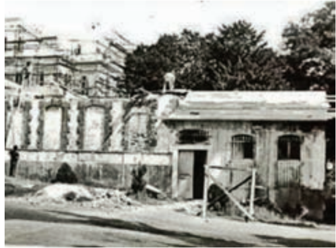
21-22 Ağalar Dairesi restorasyon çalışmaları.
