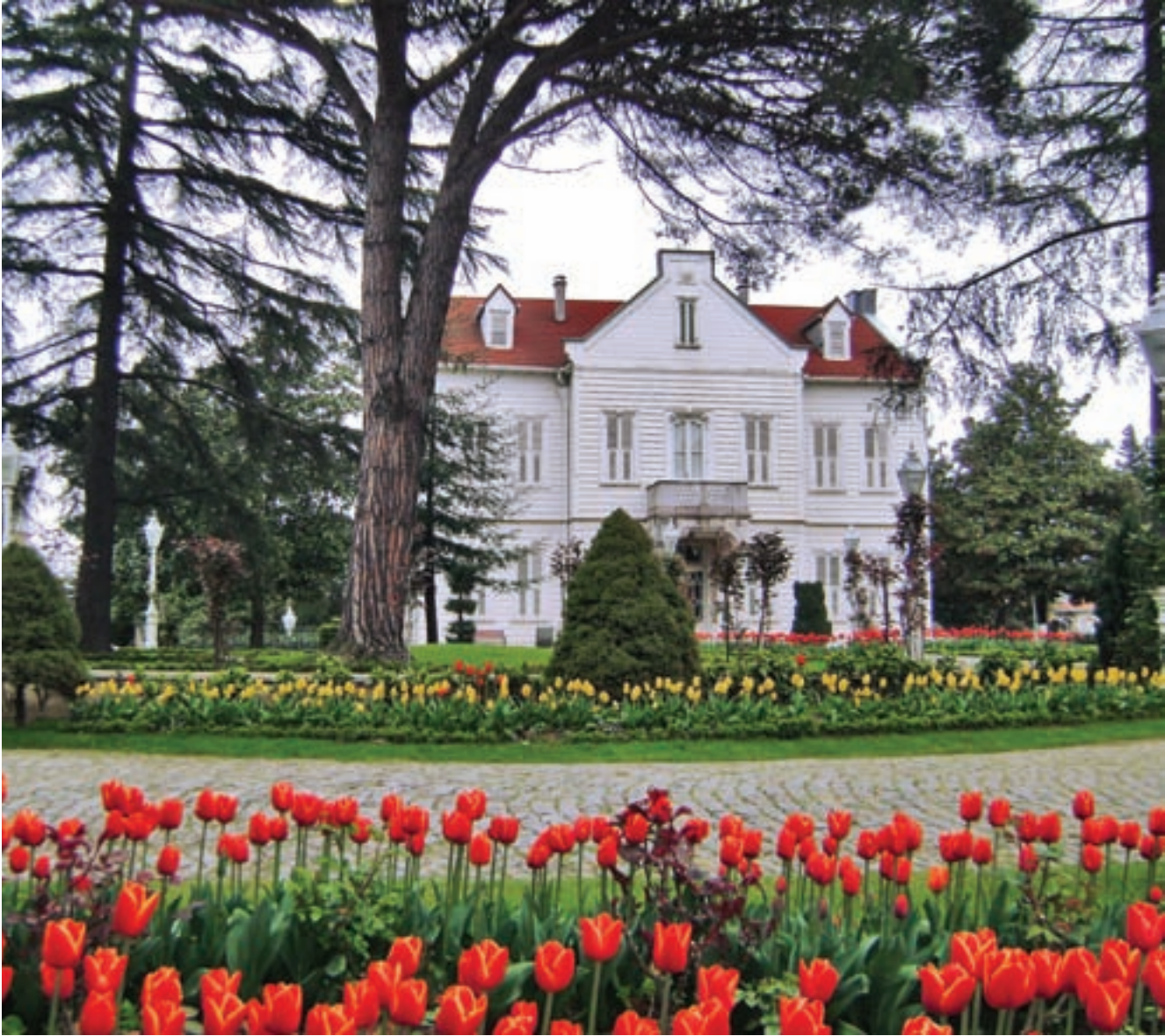
48 Milli Saraylar tarafından restorasyonu gerçekleştirilen Maslak Kasırları ana binasının günümüzdeki görünümü.
